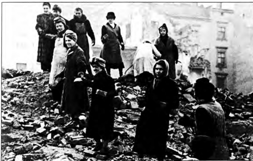
Entrümmerungsarbeiten in Dresden im Frühherbst 1945. Geputzte Ziegel wandern von Hand zu Hand.
