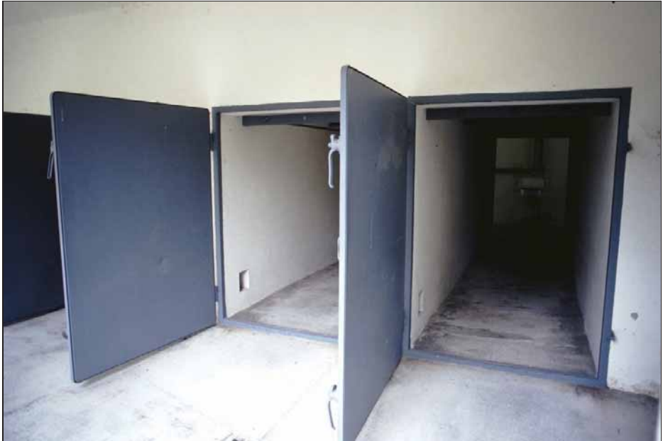
Abbildung 70: Gasdichte, ausbruchsichere Stahltüren der DEGESCH-Kreislauf-Entlausungsanlagen im Lager Dachau. (1998)
