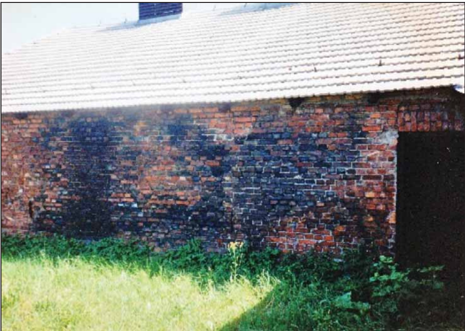
Abbildung 114: Nördliche Außenmauer des Zyklon-B-Entwesungstrakts von Bauwerk 5b im Lager Birkenau. (© Carlo Mattogno)
