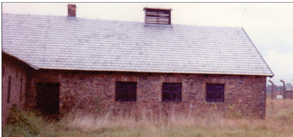
Abbildung 164: Entwesungstrakt des Bauwerks 5a, Nordwand mit leichter Verfärbung. (© C. Mattogno 1991)
