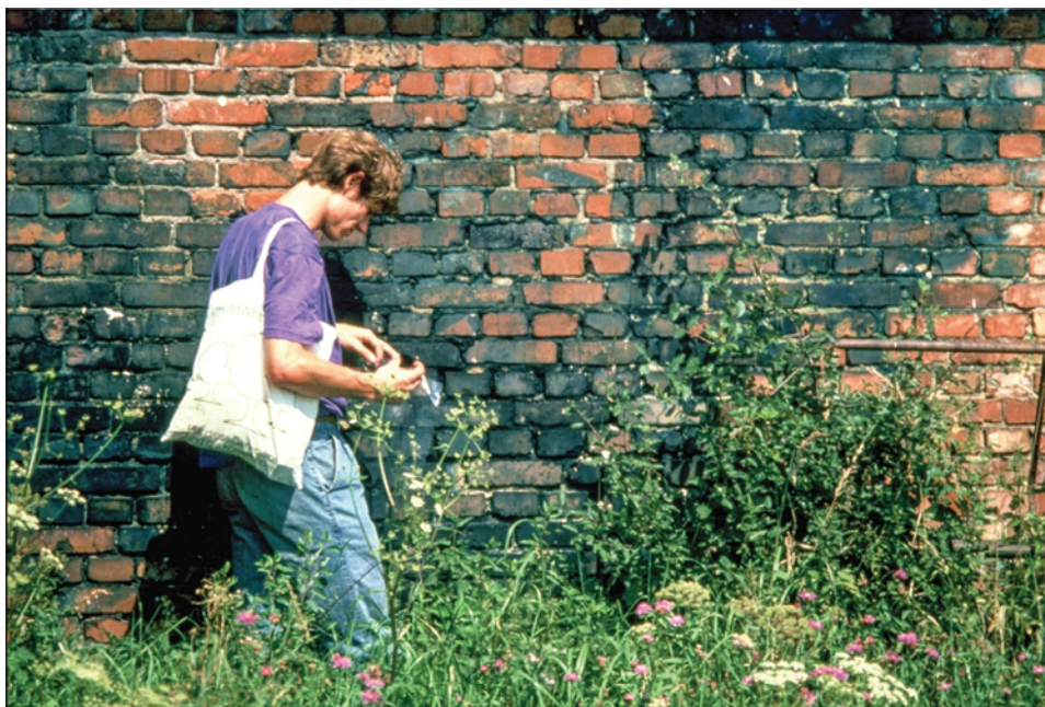
Abbildung 148: Im Gegensatz zum Bauwerk 5a (siehe Abbildungen 142, 164-166) wurde der Entwesungstrakt des Bauwerks 5b länger als Blausäure-Entwesungskammer benutzt. Dementsprechend ist dessen Außenmauer über große Flächen blau gefärbt, auch hier unbeeindruckt von 50 Jahren Witterungseinflüssen. Hier die Südwand (August 1991, mit dem Autor).
