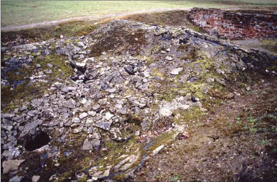
Abbildung 62: Leichenkeller 1 von Krematorium II in Birkenau, kollabiertes Dach, einigermaßen erhaltener hinterer Teil. Links: quadratisches Loch, nach der Zerstörung des Dachs hindurchgemeißelt, die Bewehrungsseisen nur zurückgebogen (siehe Abb. 84, S. 140). (Februar 1997)
