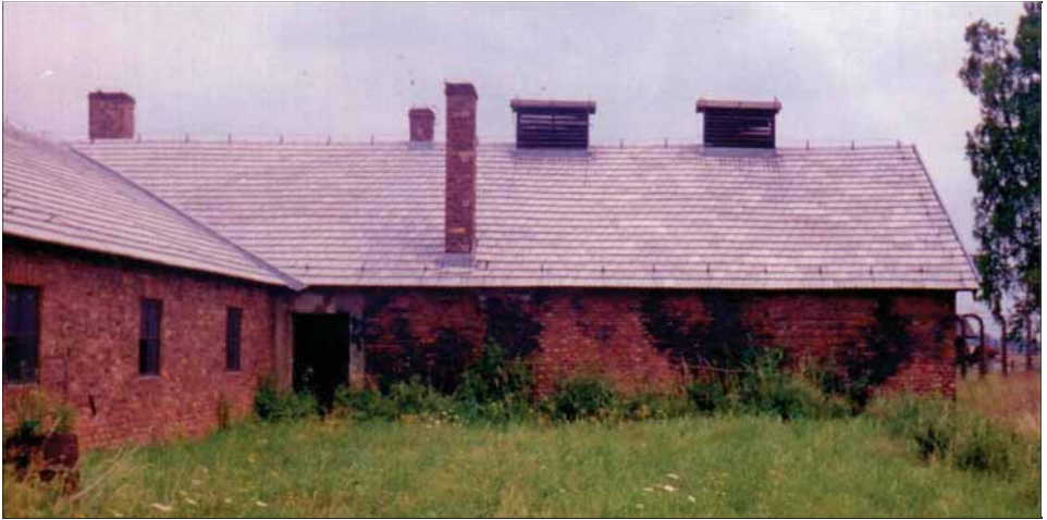
Abbildung 162: Entwesungstrakt des Bauwerks 5b, Südmauer mit intensiver Verfärbung. (© C. Mattogno 1992)
