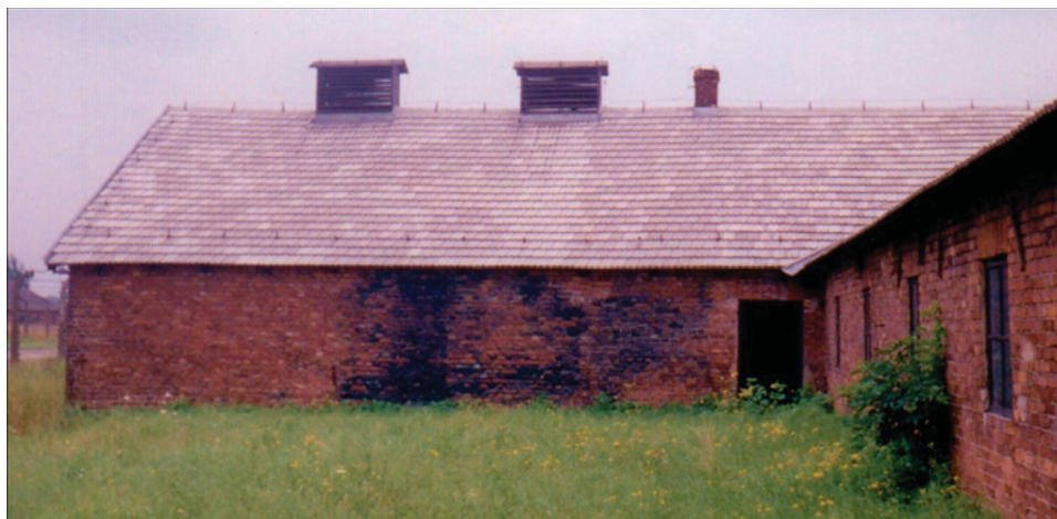
Abbildung 161: Entwesungstrakt des Bauwerks 5b, Nordmauer mit intensiver Verfärbung. (© C. Mattogno 1992)
