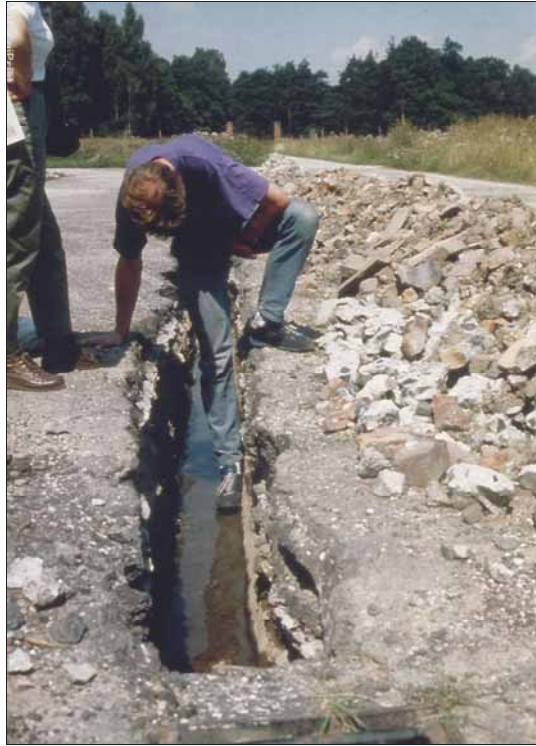
Abbildung 109: Grundwasserstand im Lager Birkenau im Hochsommer 1991 – in einem Baugraben mit dem Autor (Mitte) und Anita Philipp (links) vor der Zentralsauna: etwa 70 cm.
