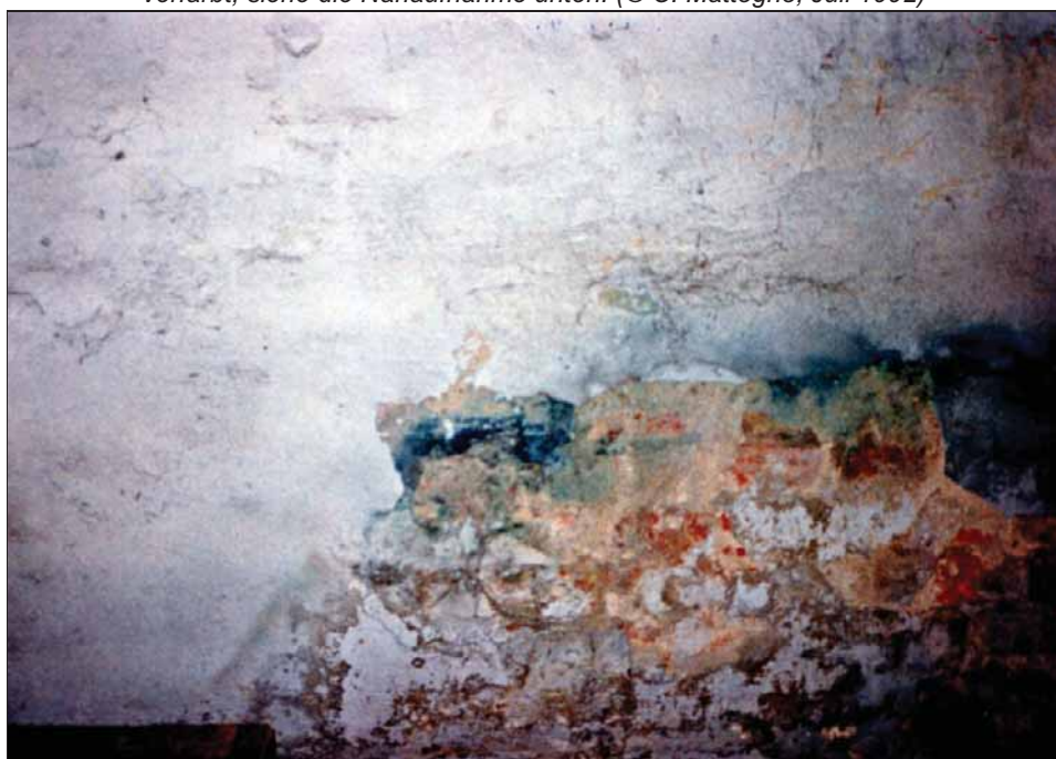
Abbildung 146a&b: Innenaufnahme des Entwesungstrakts des Bauwerks 5b, westlicher Teil der Südmauer. Der kalkreiche Innenverputz ist nur wenig verfärbt. Er ist in Bereichen abgefallen. Der drunter befindliche Mörtel ist weitaus stärker bläulich verfärbt, siehe die Nahaufnahme unten. (© C. Mattogno, Juli 1992)
