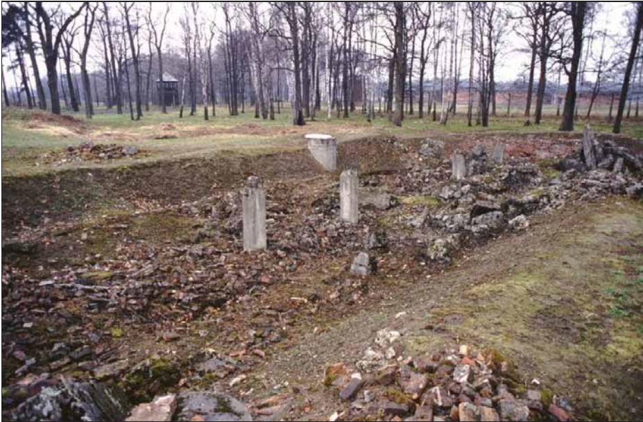
Abbildung 68: Leichenkeller 1 des Krematoriums III mit einem völlig zerstörtem Dach (Februar 1997).
