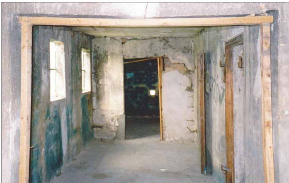
Abbildung 151: Entwesungstrakt des Bauwerks 5a, mit südlicher Außenmauer zur Linken. Blick durch Raum 2 in den Raum 3 im Hintergrund (siehe Abbildung 41). (© C. Mattogno 1992)
