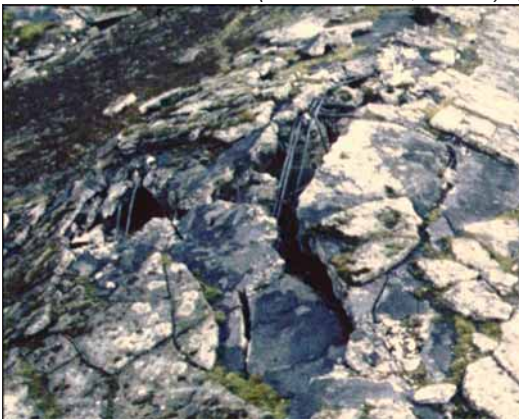
Abbildung 63a: Leichenkeller 1 von Krematorium II in Birkenau, kollabiertes Dach, einigermaßen erhaltener, noch zugänglicher hinterer Teil. Rechts: Die letzte der sieben Betonsäulen ragt aus dem Dach hervor. Etwa einen Meter links davon: ein durch das Dach gemeißeltes Loch, um Zugang zum Bereich darunter zu erhalten (siehe Abb. 82, S. 138). (Februar 1997)
