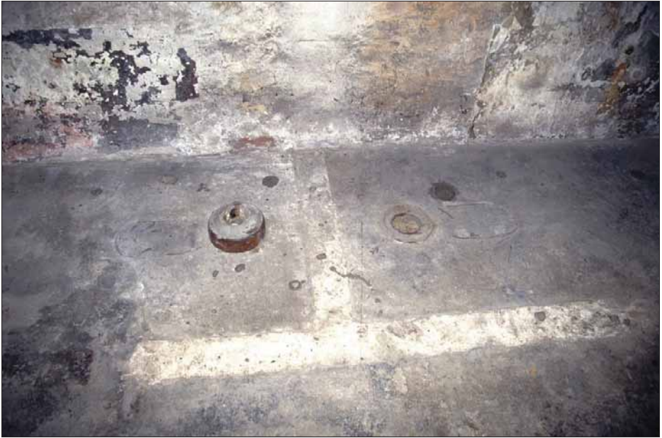
Abbildung 51: In der "Gaskammer" können die Besucher die Kloabflussrohre und die Spuren der Trennwände der Kabinen auf dem Boden bewundern, die aus der Zeit stammen, als das Krematorium als Luftschutzbunker diente.
