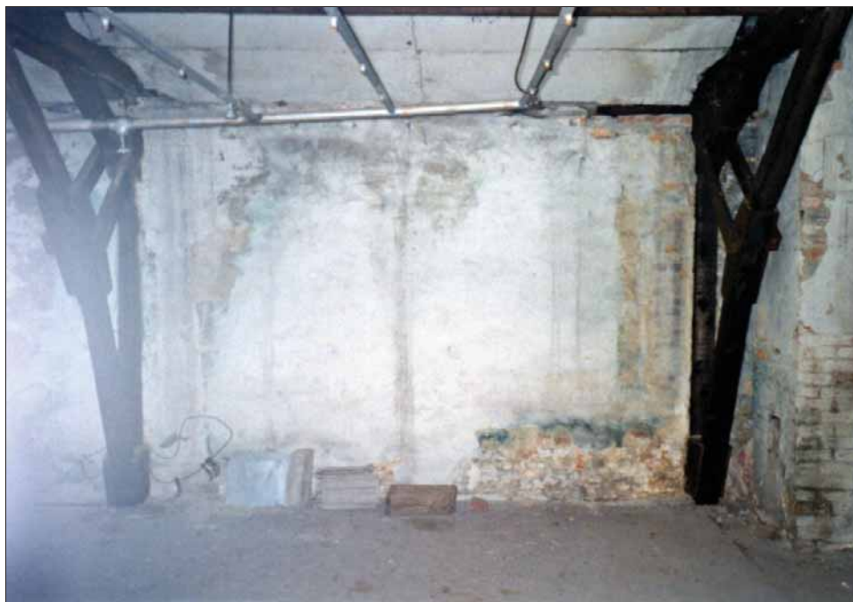
Abbildung 146a&b: Innenaufnahme des Entwesungstrakts des Bauwerks 5b, westlicher Teil der Südmauer. Der kalkreiche Innenverputz ist nur wenig verfärbt. Er ist in Bereichen abgefallen. Der drunter befindliche Mörtel ist weitaus stärker bläulich verfärbt, siehe die Nahaufnahme unten. (© C. Mattogno, Juli 1992)
