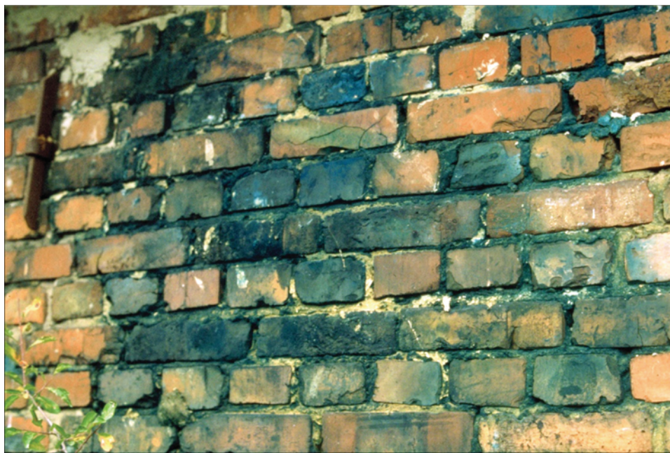
Abbildung 150: Detail der südlichen Außenwand des Bauwerks 5b. (Juli 1992)
