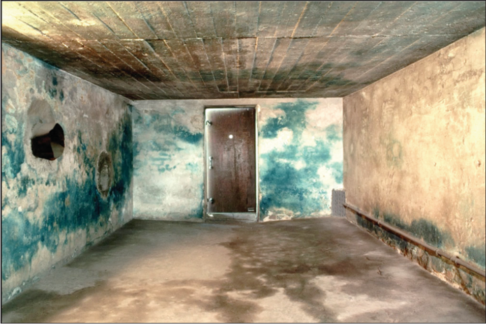
Abbildung 116: Zyklon-B/Heißluft-Entwesungsanlage, Kammer III der Baracke 41 im KL Majdanek. (© Carlo Mattogno 1992)
