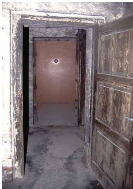
Abbildung 48: Blick von innen in die Luftschleuse des vormaligen SS-Luftschutzbunkers, mit der Luftschutztür im Hintergrund.
