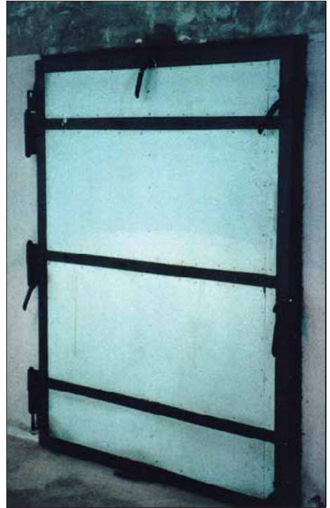
Abbildung 72: Gasdichte, ausbruchssichere Stahlrahmentür einer der DEGESCH-Kreislauf-Entlausungsanlagen im Lager Buchenwald. (© C. Mattogno)
