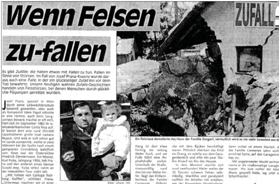
Abbildung 88: Effekt der Kerbwirkung an einspringenden Ecken bei Gewalteinwirkung. Der einzige Riss durch die Wand geht naturgemäß von der Ecke des Fensters aus ("Wenn Felsen zu-fallen", Kurier, 30.8.1992, S. 20).
