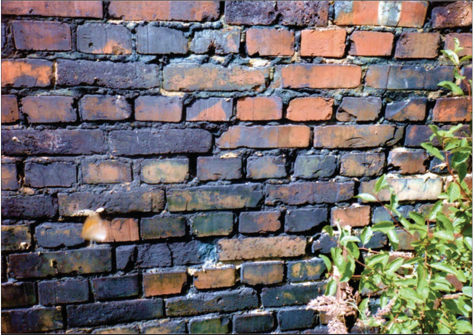
Abbildung 163: Entwesungstrakt des Bauwerks 5b, Südmauer, in der Nähe der Eingangstür gemachte Nahaufnahme mit intensiver Verfärbung. (© C. Mattogno 1992)
