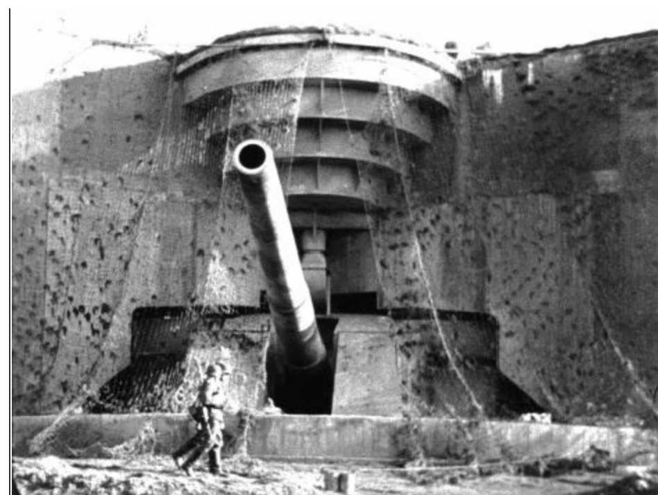
Eine Küstenbatterie mit Tarnnetzen. Während der alliierten Landung in der Normandie bombardierten vier Schlachtschiffe eine ähnliche Artilleriestellung in Houlgate. Die Batterie wurde über 1000 Mal getroffen, darunter mehrmals von Geschossen mit 38 cm Durchmesser sowie von Flugzeughomben, ohne ernsthaften Schaden davonzutragen.
