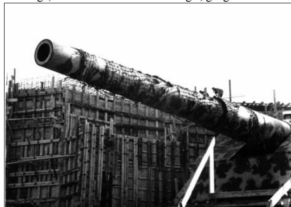
Batterie "Lindemann" am Atlantikwall. Die Deutschen errichteten massive Betonbunker, um ihre Küstenartillerie vor alliierten Bombardierungen aus der Luft und von der See her zu schützen.
